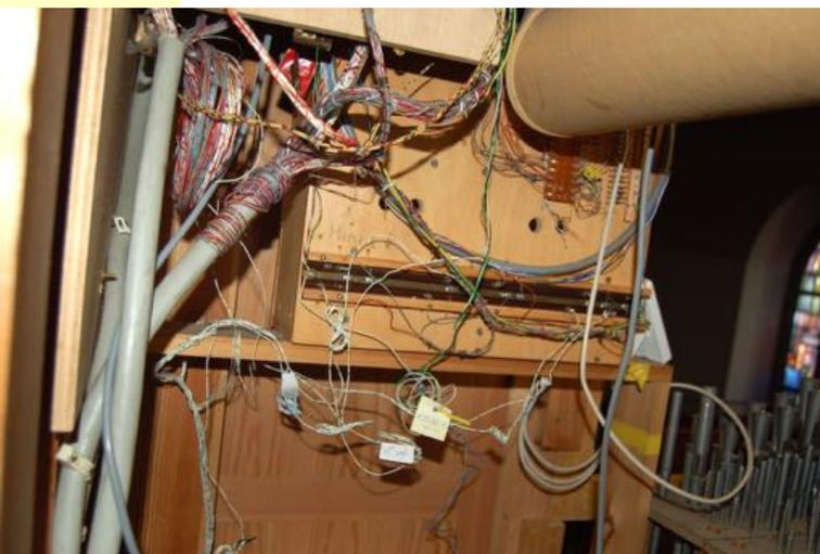
*Die Orgel wird auch nach 1984 elektrisch angesteuert. Die Vergrößerung und eine Menge technischer Raffinessen verlangen nach einer ausgeklügelten Verkabelung. Diese wird so unübersichtlich, dass am Schluss niemand mehr genau weiß, welcher Draht was ansteuert. Neue Vorschriften im Bereich Niederspannung führen dazu, dass diese komplette Technik als veraltet zu betrachten ist und ersetzt werden müsste.*
